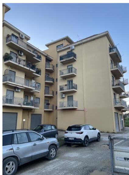
Foto n. 5 – Vista prospetto secondario
